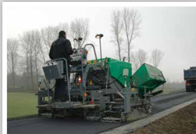
ASPHALTEINBAU AUF DÄMMEN
