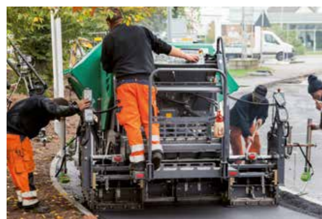
BAU VON WIRTSCHAFTSWEGEN
