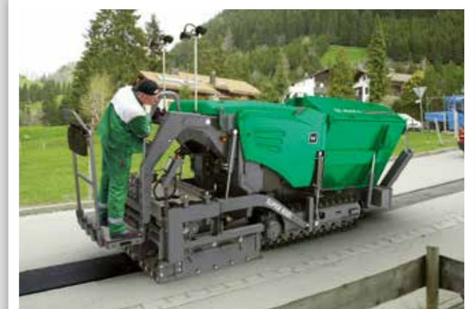
BEFÜLLEN VON KANALGRÄBEN
