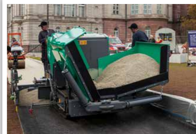
BAU VON RAD- UND FUSSWEGEN
