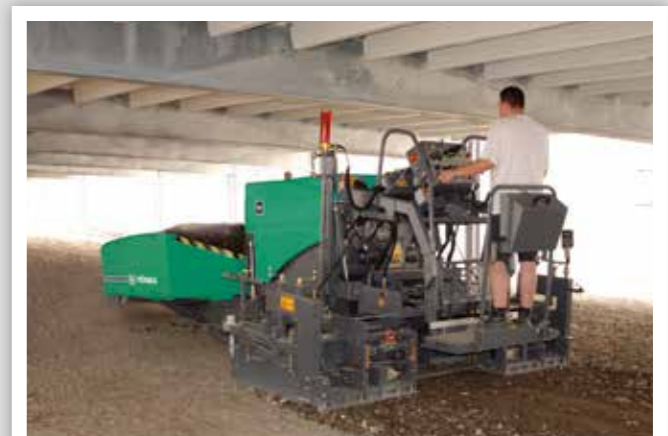
HERSTELLUNG DES UNTERBAUS FÜR PFLASTERSTEINE
